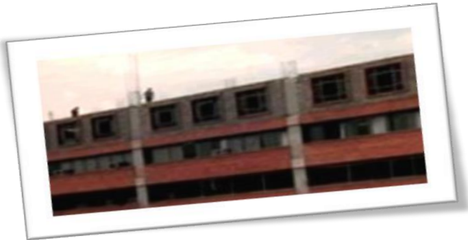
Vista de la planta física de las Unidades Tecnológicas de Santander cuando inició la construcción del cuarto piso sobre el edificio de Aulas y Laboratorios. Año 2000
